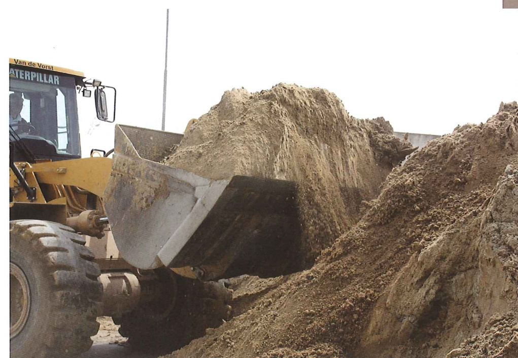
Voortschrijdende werkzaamheden, zoals grondwerk door graafmachines, het aan- en afrijden van vrachtwagens voor het af- of aanvoeren van grond en asfaltrezen, vallen niet onder de eisen voor bouwlawaaai en trillings- en stofhinder als gevolg van bouw- en sloopwerken in het concept Bouwbesluit 2012.
