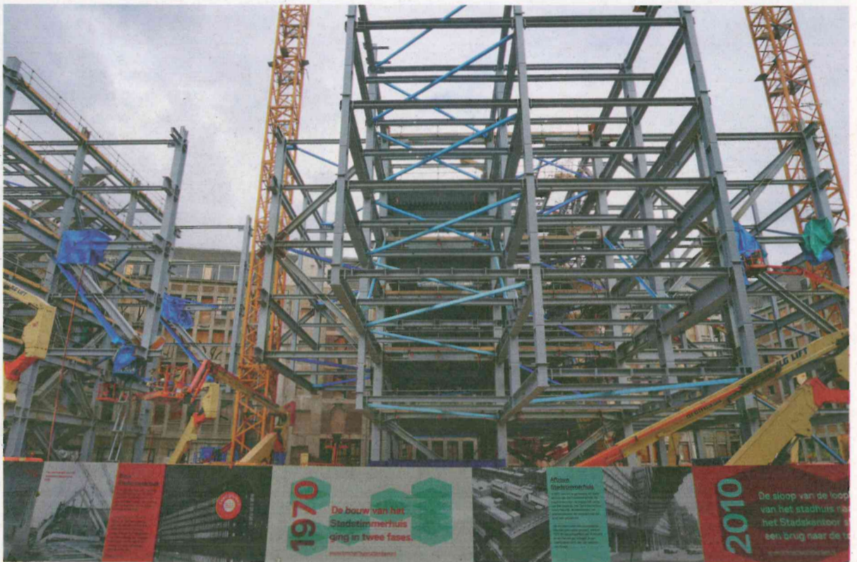
Het Timmerhuis in Rotterdam is een voorbeeld van een project waarbij frictie tussen de architectuur van staalconstructies en brandveiligheid kan ontstaan.
