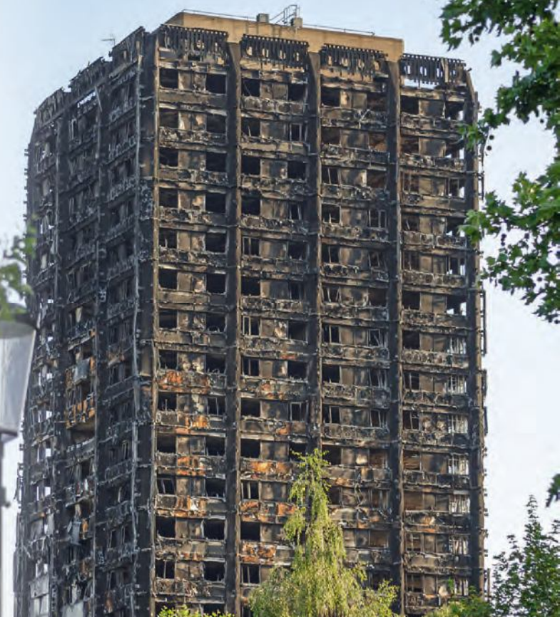
De verkoolde resten van de gevel van Grenfell Tower
