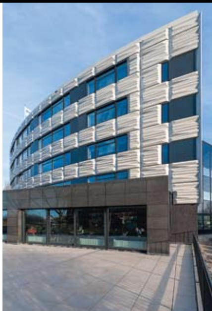
▲ De gevel is geïsoleerd en voorzien van fraaie kunststof panelen.
