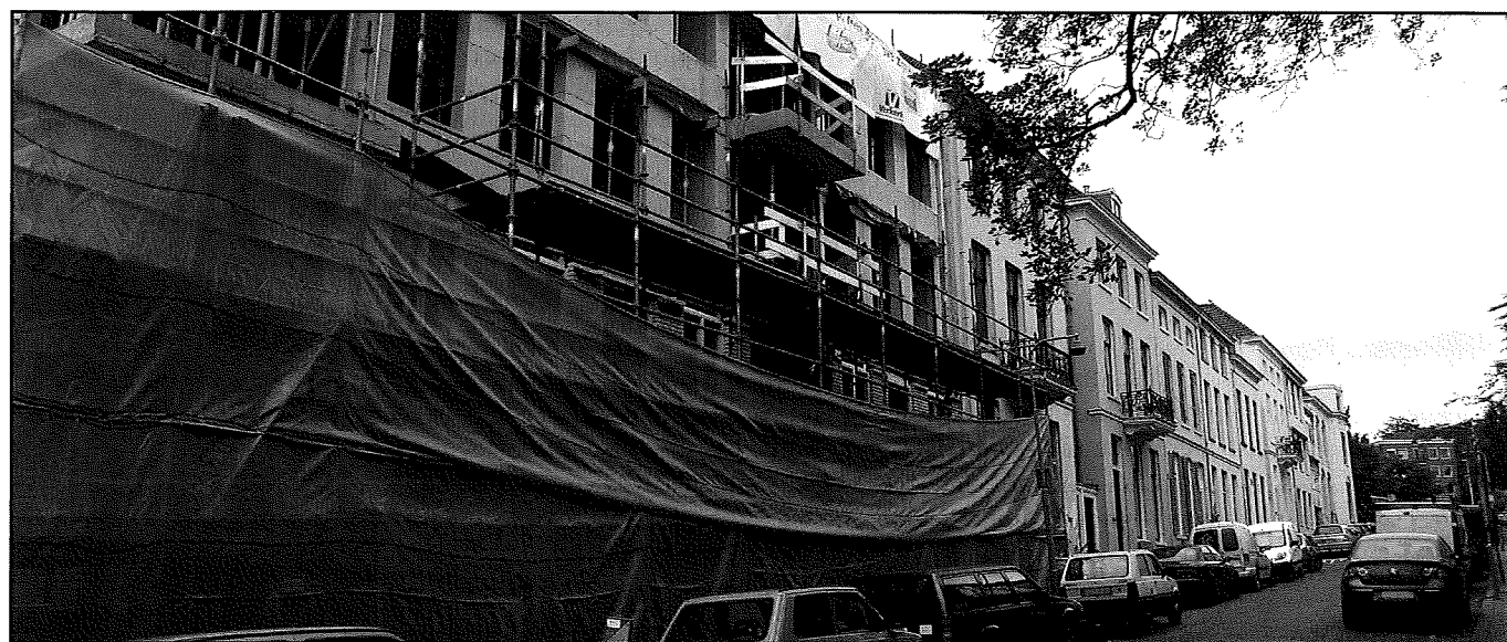
REALISATIE WONINGBOUW NAAST BESTAANDE WONINGEN
