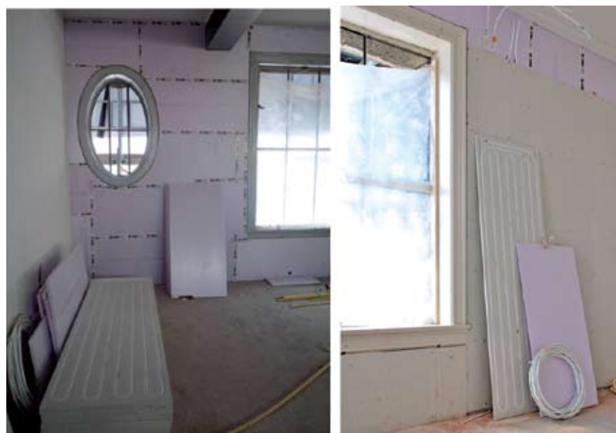
▲ Werk in uitvoering. Het aanbrengen van isolatie en gevelverwarming.
