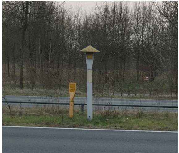
Brandaandachtsgebieden door een fakkelbrand gelden bijvoorbeeld langs hogedruk aardgasleidingen. Die leidingen zijn vaak te herkennen aan de palen met het karakteristieke hoedje.
