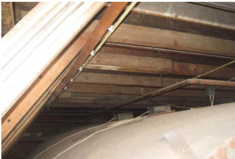
Foto 2: Ruimte die voorzien moet worden van sprinklers.
