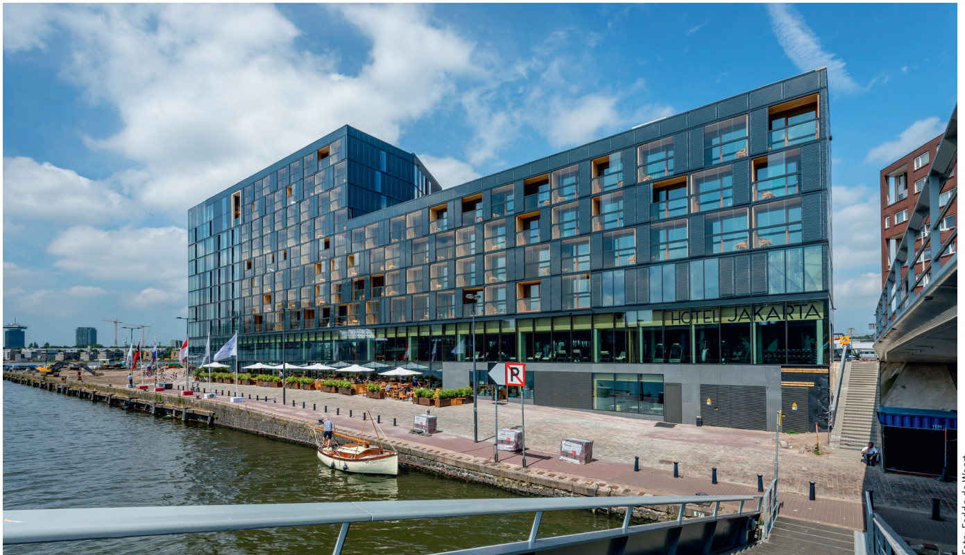
PV-panelen in de gevel bij het duurzame Hotel Jakarta in Amsterdam.
