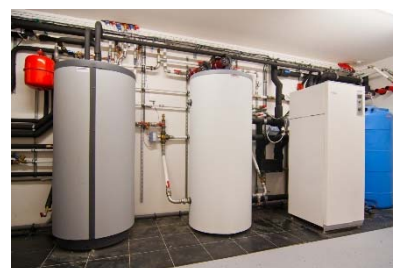
figuur 7 Warmtepomp (bodem) opslag http://www.fhloohuis.nl/Bedrijven/woningbouw/Energiebesparing/119/Energiebesparing%20Warmtepomp.html
