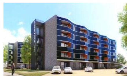
figuur 9 Zonnepanelen in gevel
